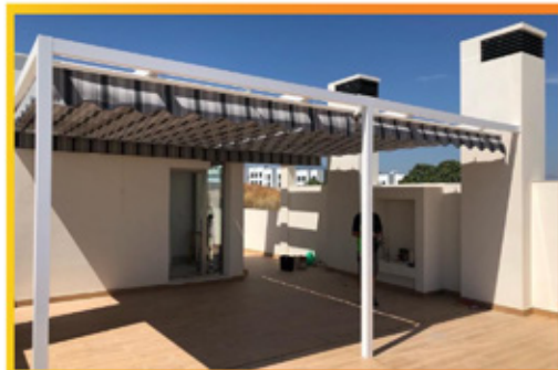
Instalación de toldo en ático
