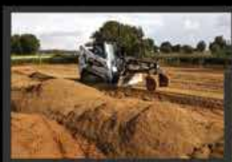
NIVELADOS CON LÁSER
